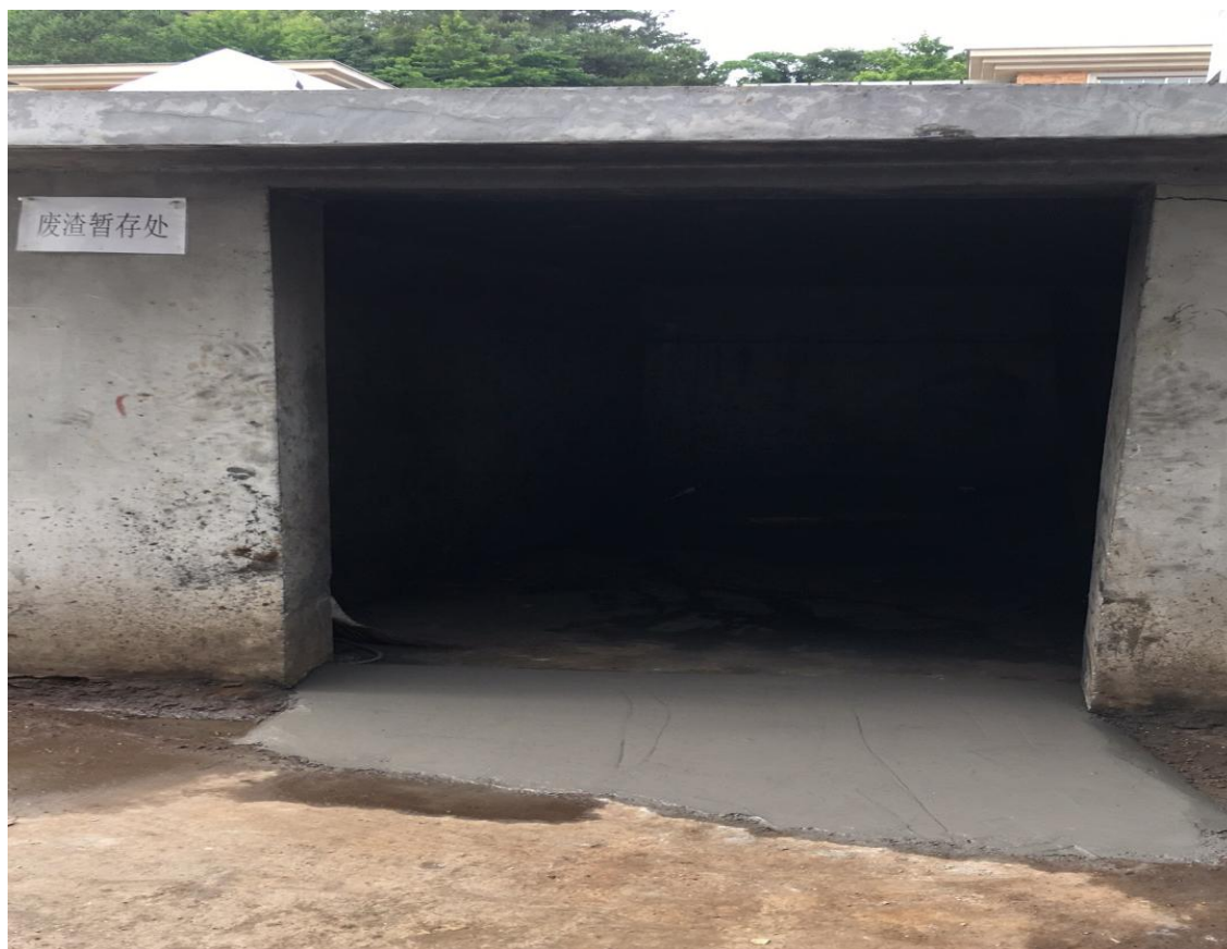
磨渣暂存处正面（整改后）
